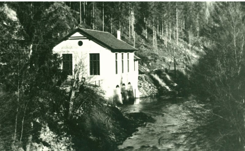
Das Kraftwerk Edelschrott – die Geburtsstätte der Köflacher Energie
